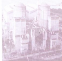
橙黄色的建筑为常规岛，安装了汽轮机和发电机组。
